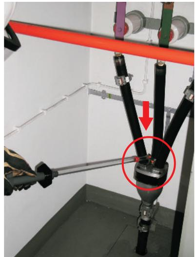
4.) Verschlusschraube mit Schraubendreher in den Endverschluß einsetzen und verschließen (siehe hierzu Bild und Publication No. 1444 "Isolierender Schraubendreher").
